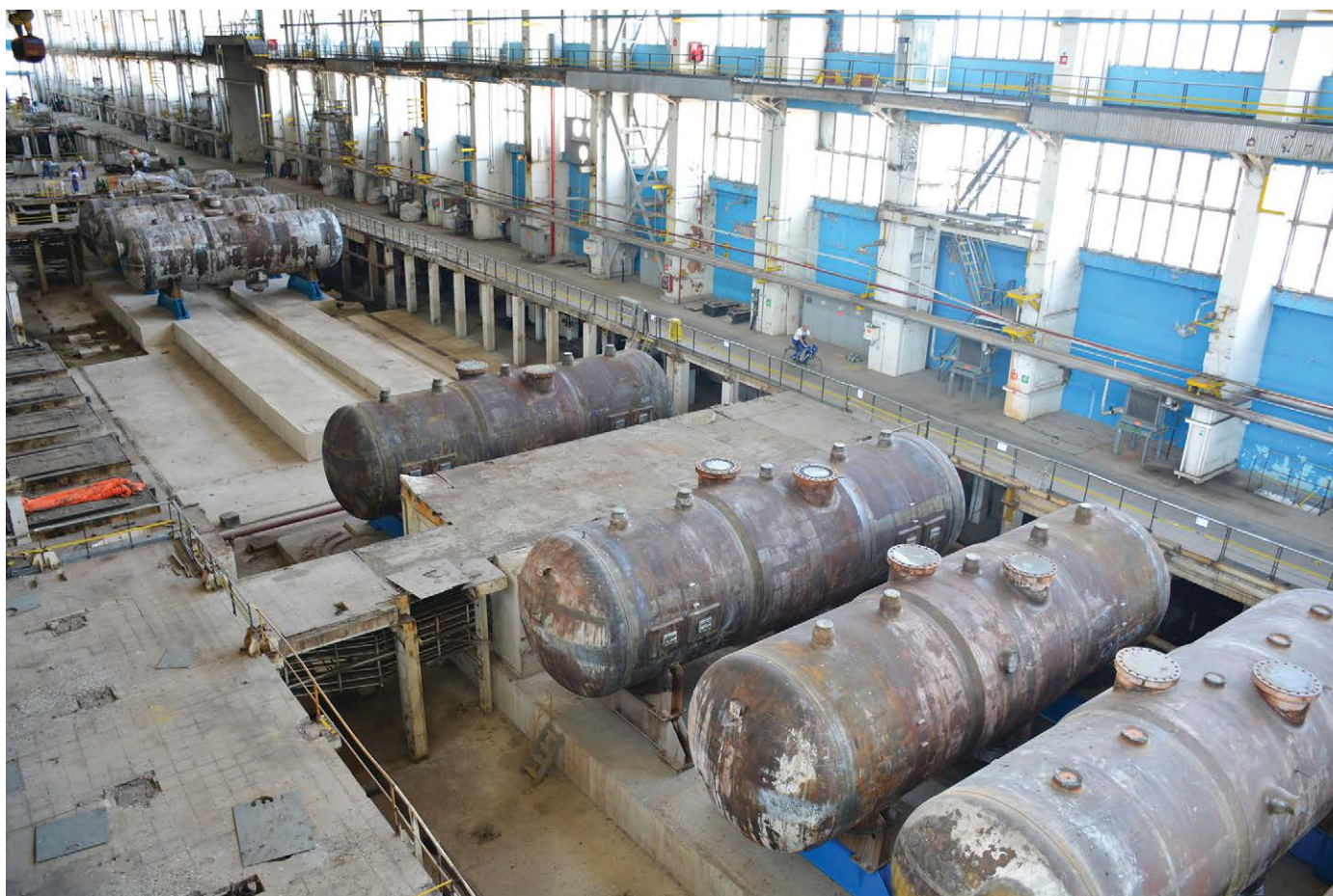
Демонтирани парогенератори от 1-4 блок, Снимка ДП РАО
