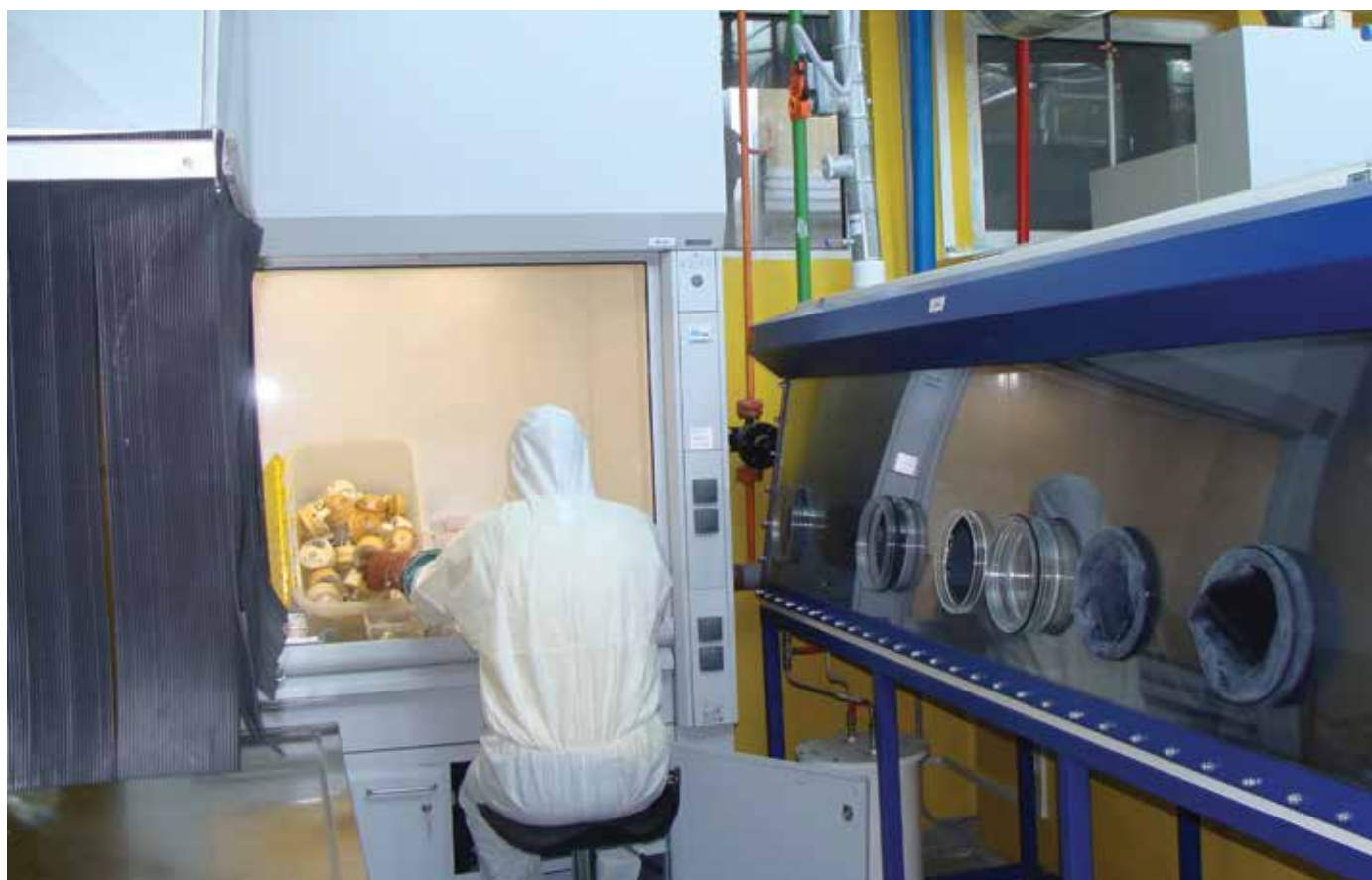
Демонтиране на източници от пожаро-известителни йонизационни датчици в Приемо-подготвителен лабораторен комплекс в СП „ПХРАО – Нови хан“, Снимка ДП РАО
