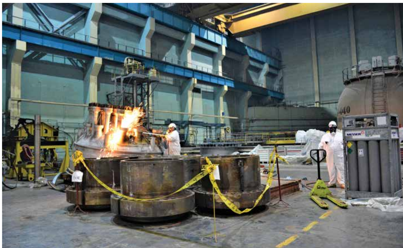
Намаляване на размерите на калпак на горен блок чрез газо-кислородно рязане, Снимка ДП РАО
