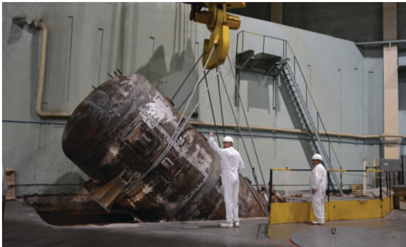
Демонтаж на парогенератор на блок 3, Снимка ДП РАО
